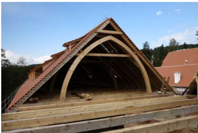
Konstrukce nového krovu nad prostorem městské knihovny, září 2014 (foto Jan Trnka)
