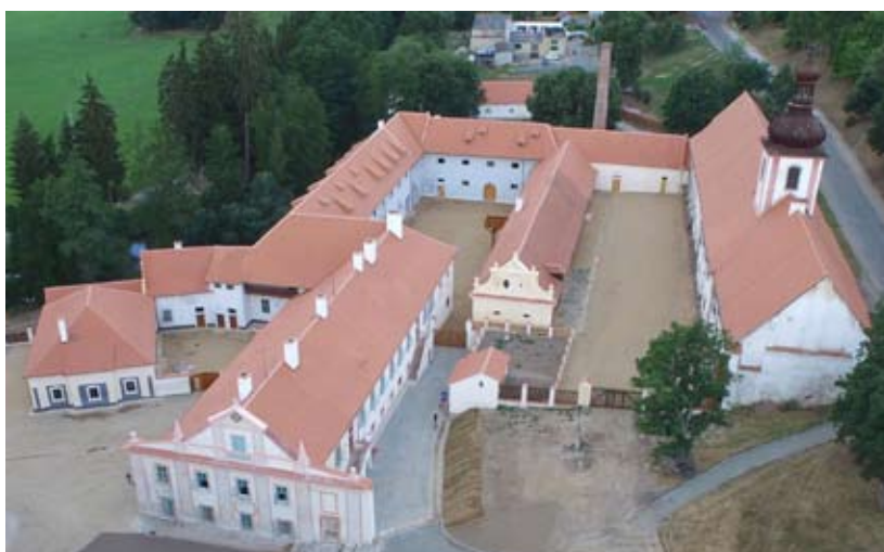
Hospodářský dvůr po dokončení stavebních prací, červen 2015 (foto Hochtief CZ a.s.)
