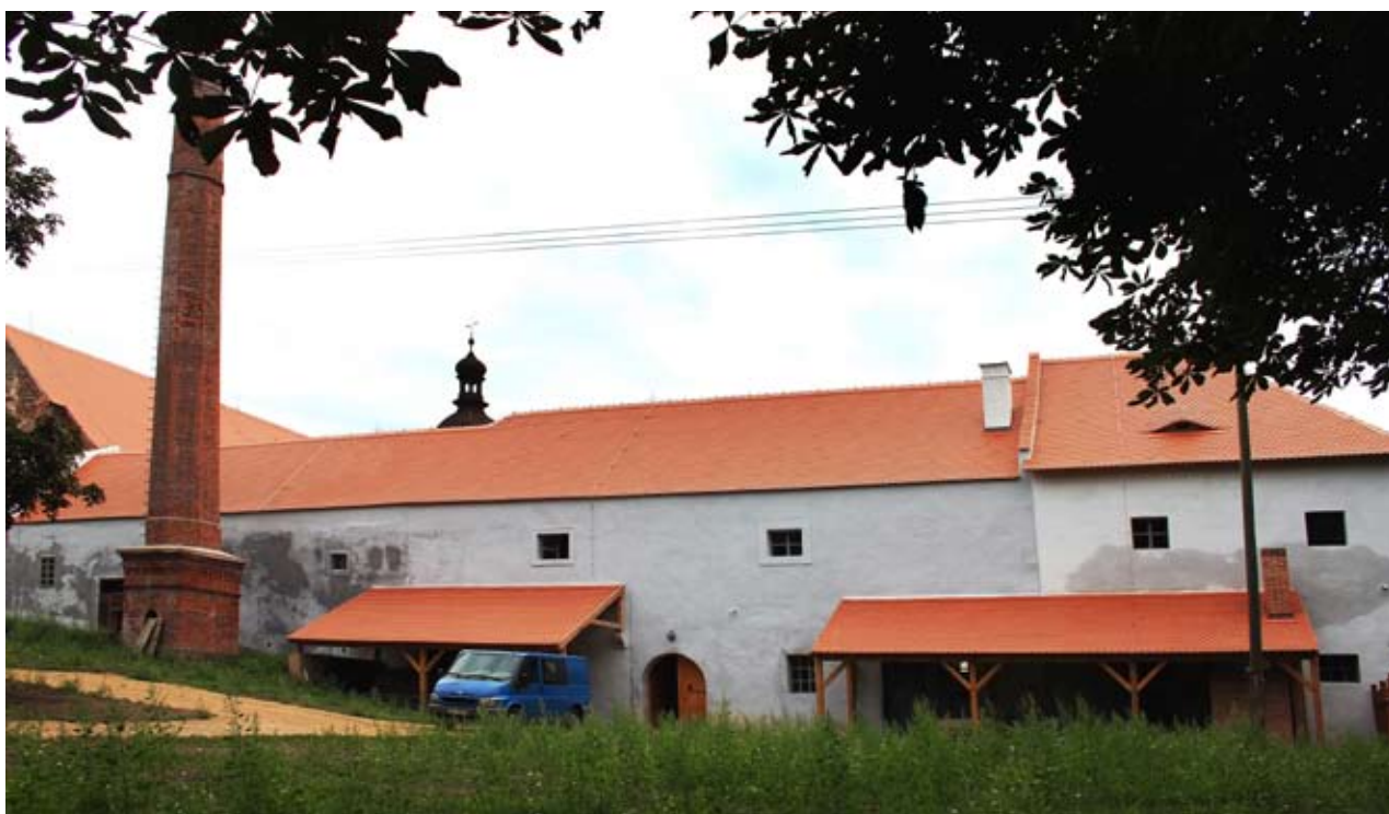
Severozápadní křídlo hospodářského dvora po památkové obnově (foto Nadežda Svobodová)
