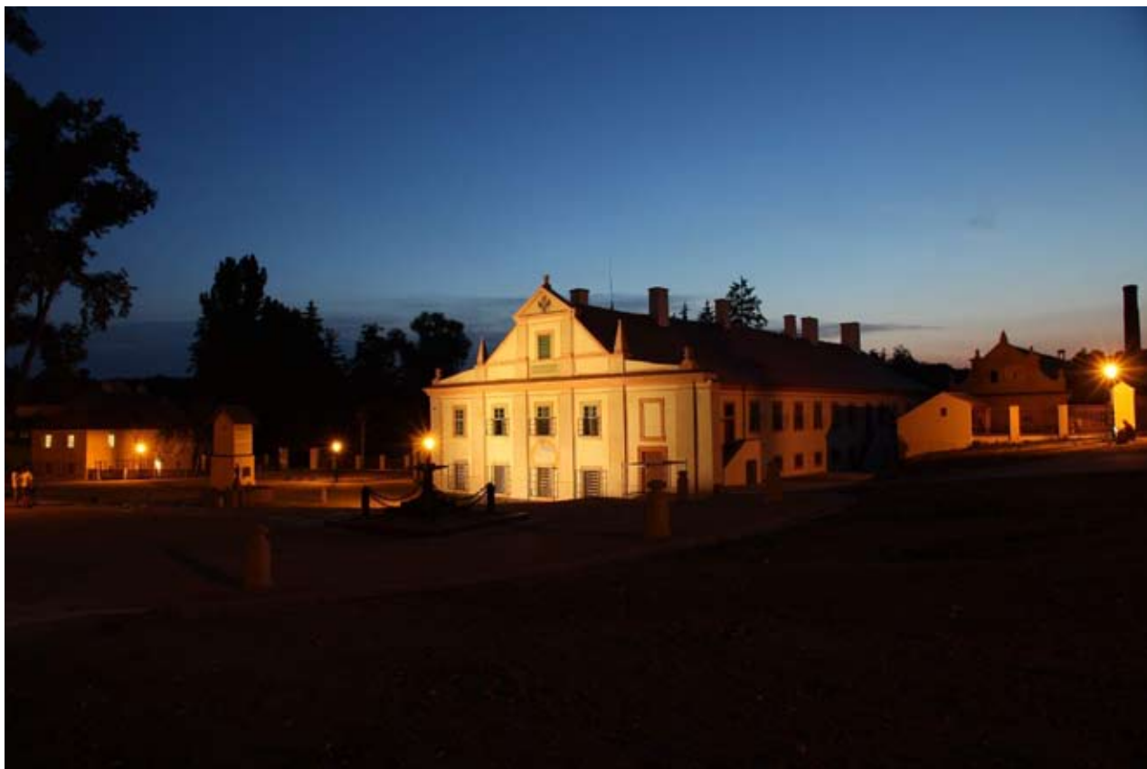
Světelná zkouška nově instalovaného veřejného osvětlení klášterního areálu, srpen 2015 (foto Martin Ebel)
