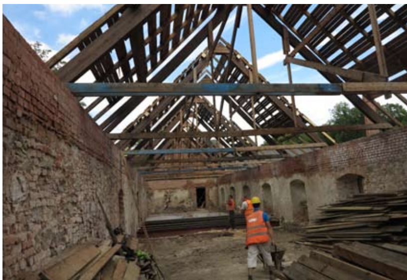
Snímání provizorních krovů v průběhu památkové obnovy, červen 2014 (foto Jan Trnka)
