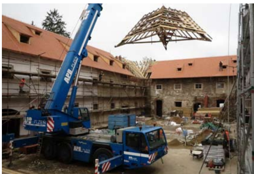
Snímání provizorního zastřešení objektů hospodářského dvora, září 2014 (foto Jan Trnka)
