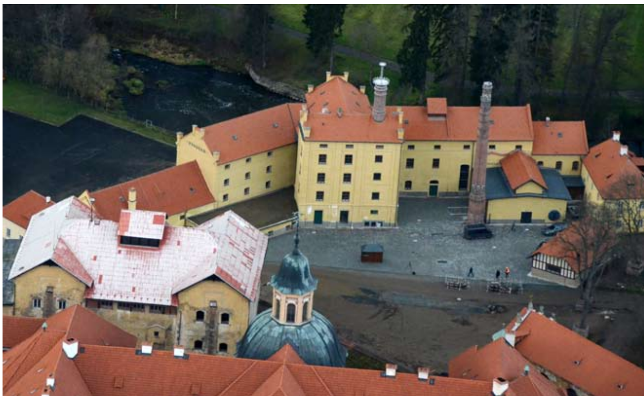
Pohled na pivovar před dokončením obnovy (foto Ivo Kornatovský)
