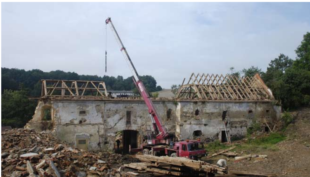
Snesení barokního krovu během demolice objektu v Podmoklech
