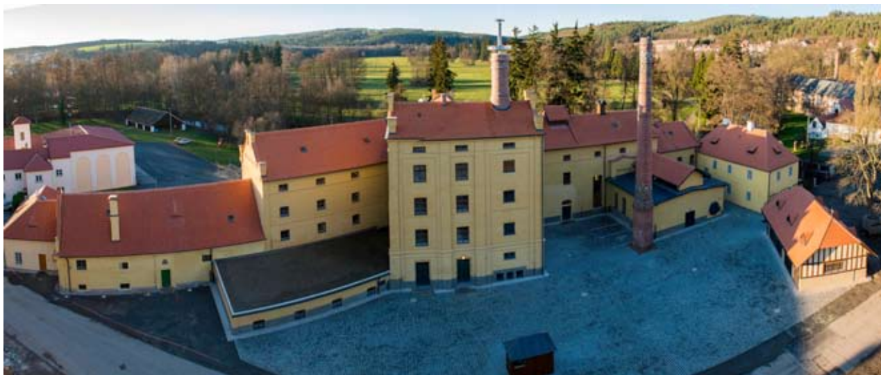
Areál pivovaru po dokončené památkové obnově, listopad 2013 (foto Ondřej Bouček, Unistav a.s.)
