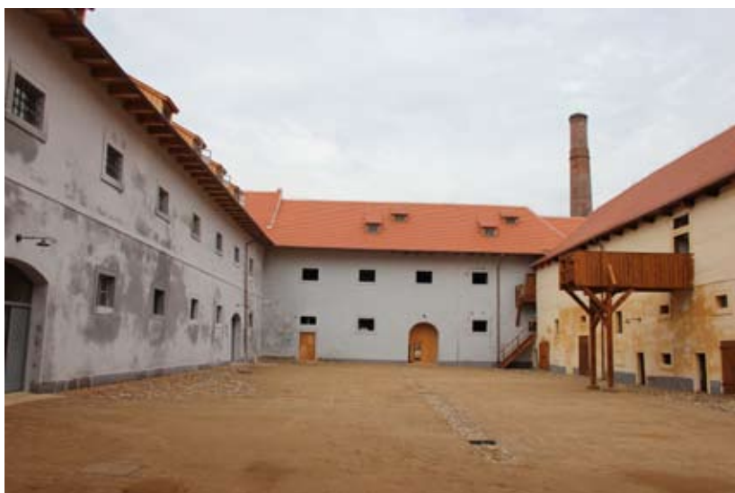
Dolejší dvůr po památkové obnově, srpen 2015 (foto Nadežda Svobodová)
