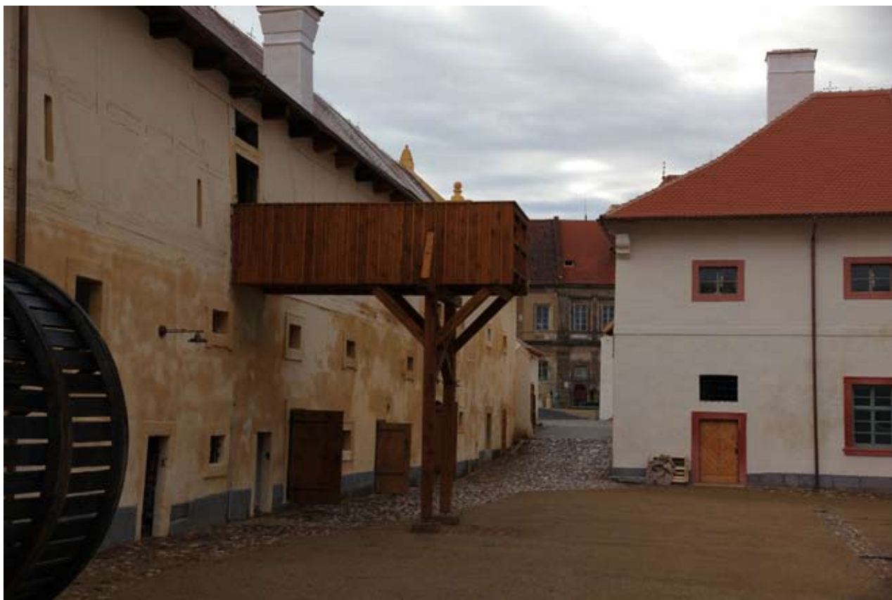
Obnovený dolejší dvůr s „hnojnou lávkou“, září 2015 (foto Martin Ebel)
