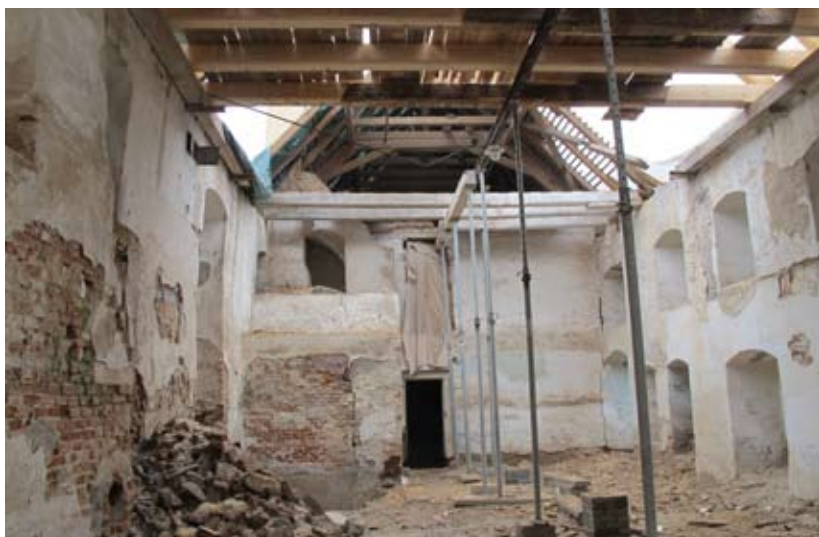
Prostor mlýna v průběhu stavebních prací, duben 2013 (foto Jan Trnka)
