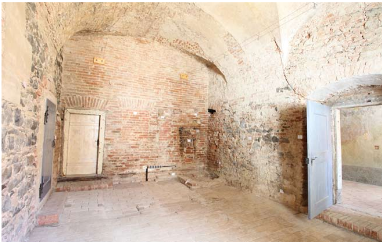
Prostor expozice stavebněhistorického průzkumu v hospodářském dvoře (foto Patrik Sláma)
