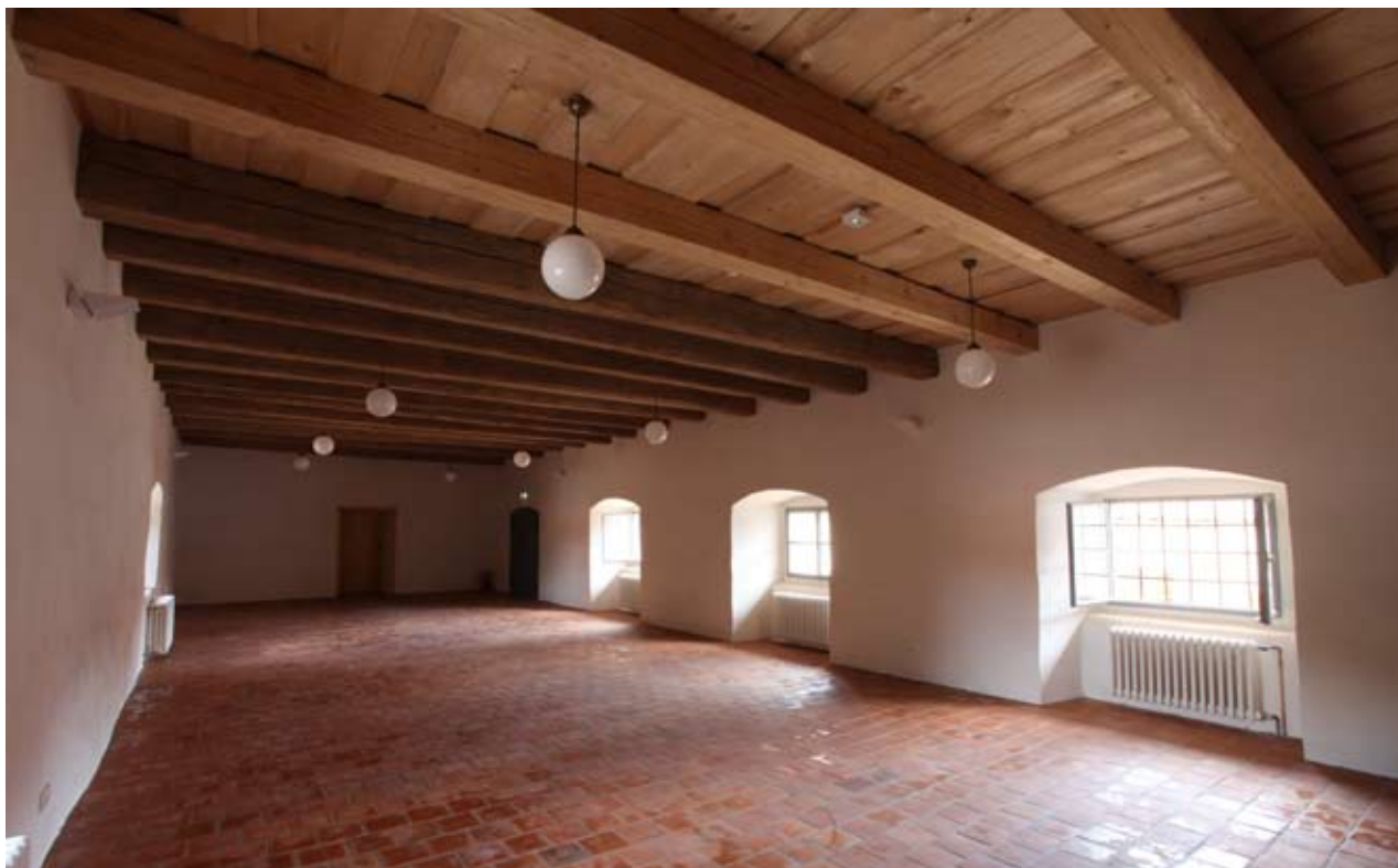
Obnovené patro západního křídla připravené pro depozitář knihovny, červenec 2015 (foto Kateřina Uksová)
