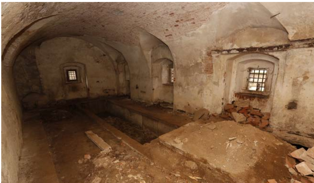
Kláštevní sádky v době zahájení stavebních prací, březen 2014 (foto Kateřina Uksová)
