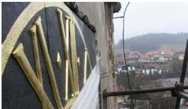
NTM nechalo restaurovat historické ciferníky na věži barokní sýpky. Obnovu provedli restaurátor kovů Jindřich Kovařík z Kralovic s uměleckým kovářem Václavem Minaříkem z Hodyně. (foto NTM)
