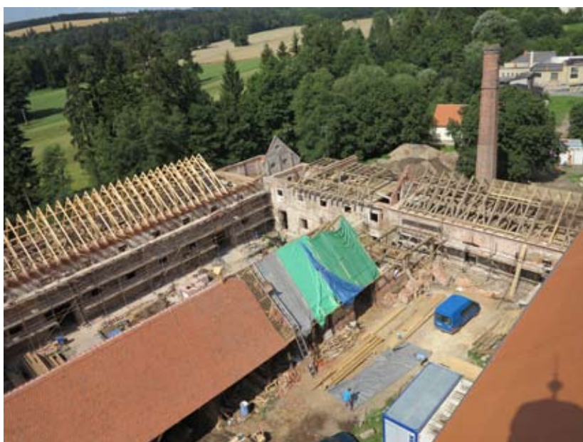
Obnova střech hospodářského dvora – nad křídlem vlevo vstýčován nový krov, vpravo historický krov v Podmokel, červenec 2014 (foto Jan Trnka)
