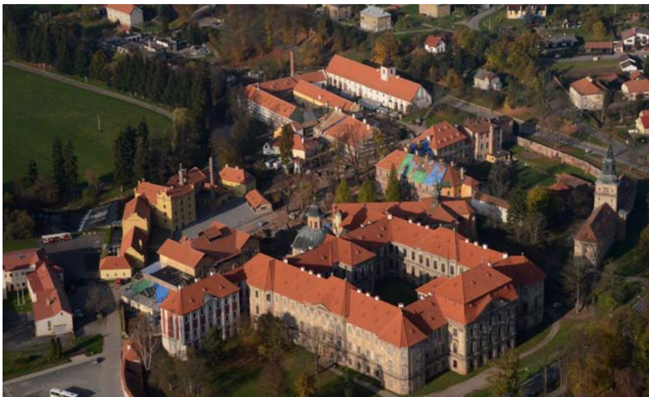
Pohled na areál kláštera v Plasích v průběhu památkové obnovy hospodářského dvora (foto Ivo Kornatovský)
