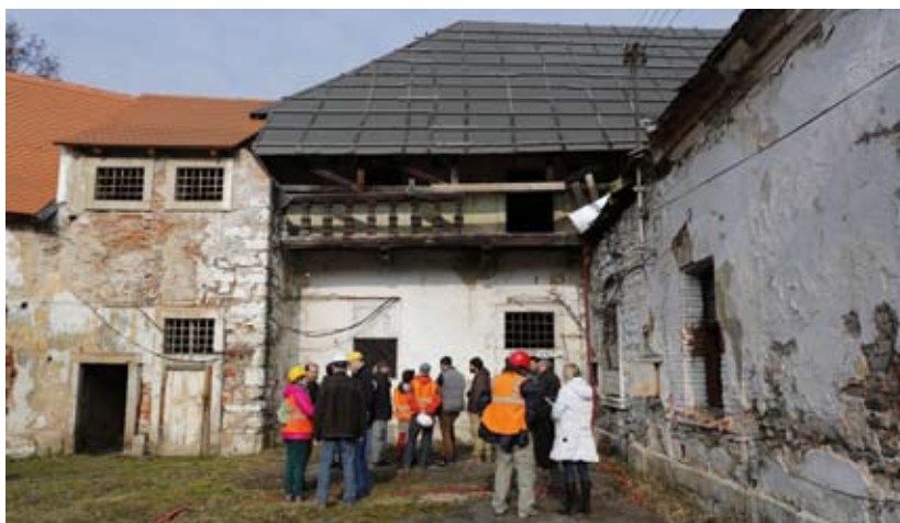
Malý dvorek při zahájení stavebních prací, březen 2014 (foto Kateřina Uksová)
