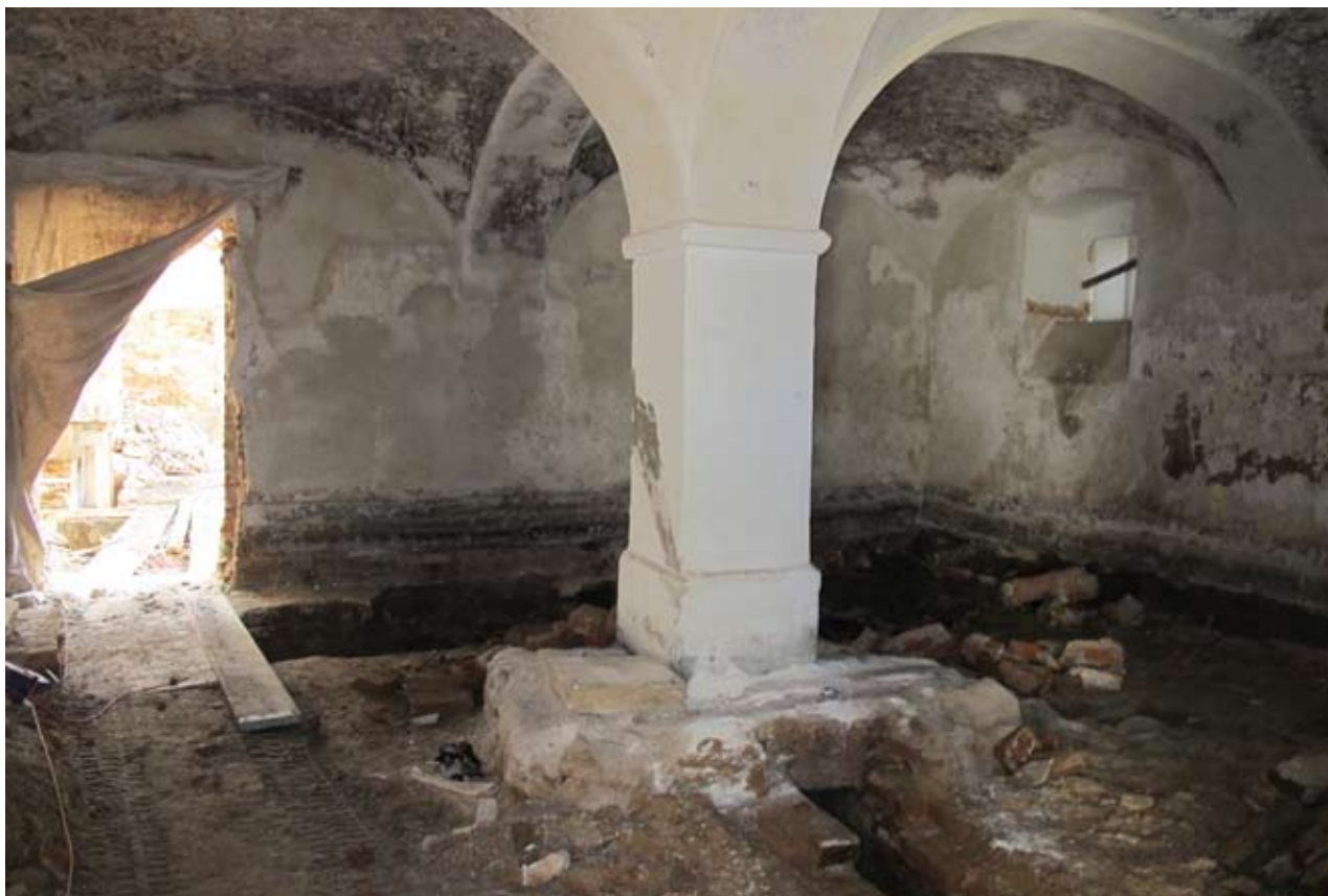
Nález systému odvodních kanálů v průběhu památkové obnovy (foto Jan Trnka)
