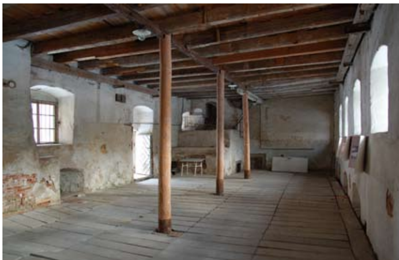
Mlýnice klášterního mlýna se zvýšenou podlahou před zahájením památkové obnovy, únor 2010 (foto Petr Dostál)
