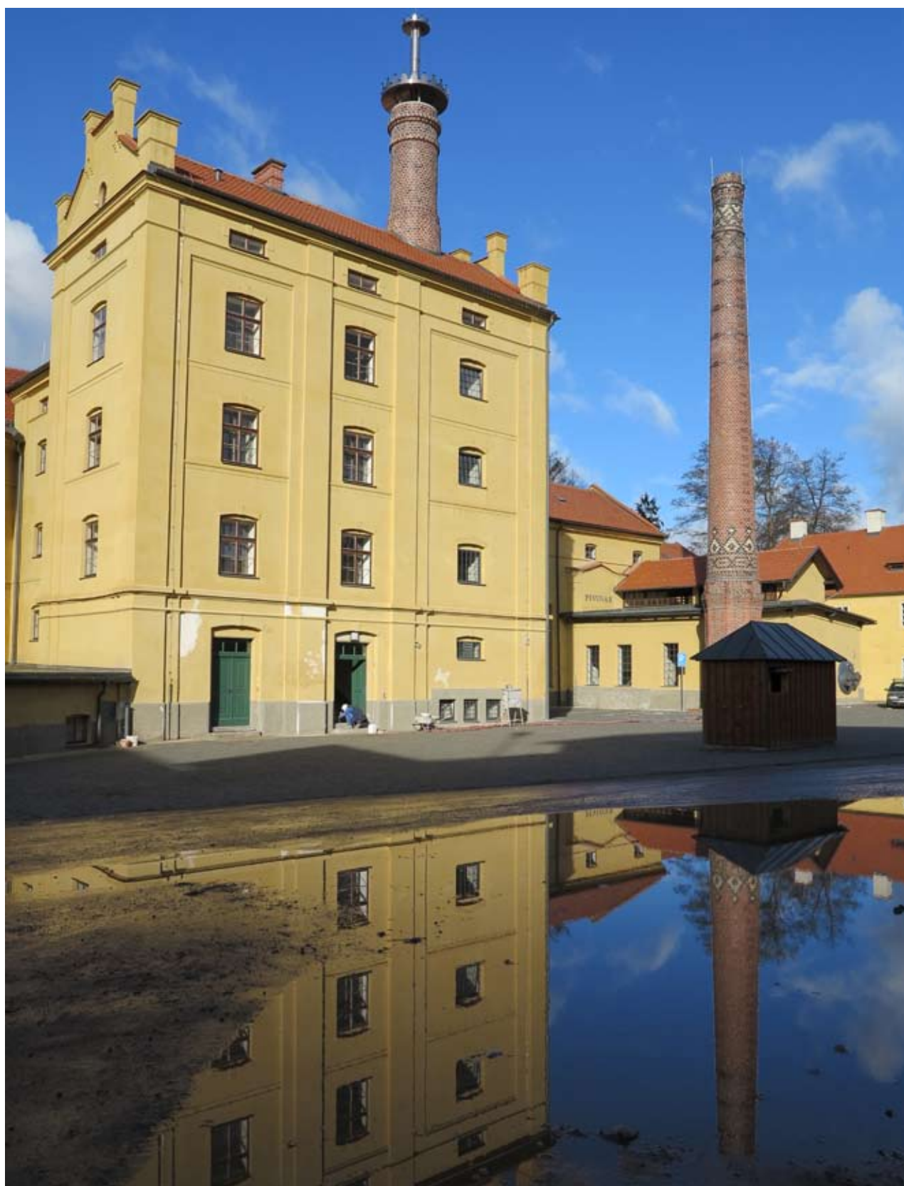
Dokončovací práce na pivovaru, podzim 2013 (foto Jan Trnka)
