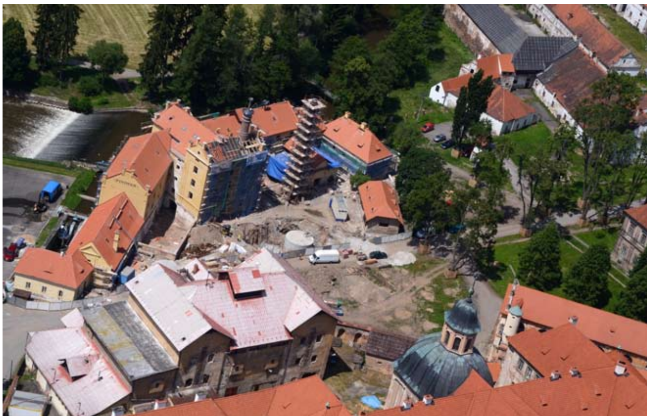
Pohled na pivovar během rekonstrukce (foto Ivo Kornatovský)
