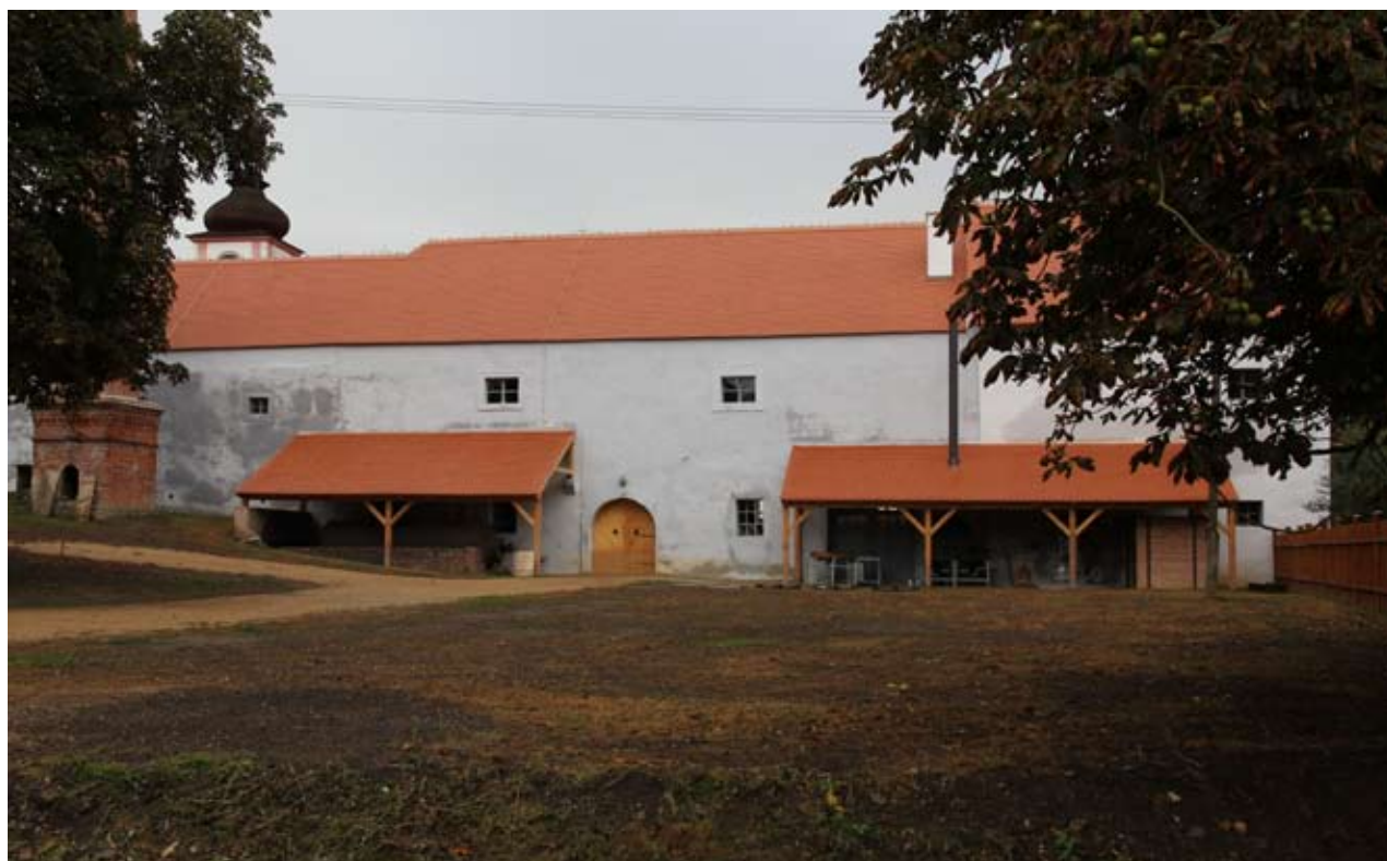
Obnovený západní trakt hospodářského dvora s přístřešky kryjícími lihovarský kotel a venkovní výheň, buchar a vysoušecí pec, září 2015 (foto Martin Ebel)
