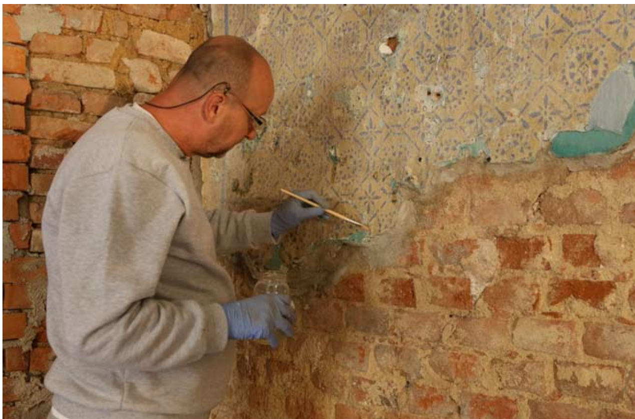
Restaurátorské práce na omítkách v šalandě klášterního mlýna (foto Kateřina Uksová)
