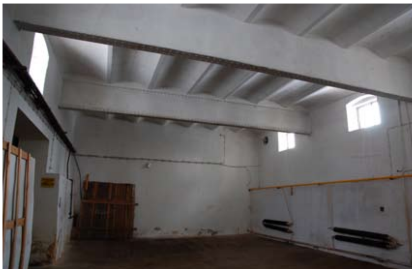
Bývalá stará chladárna se zvýšenými podlahami někdejšího velkoskladu, duben 2010 (foto P. Dostál)
