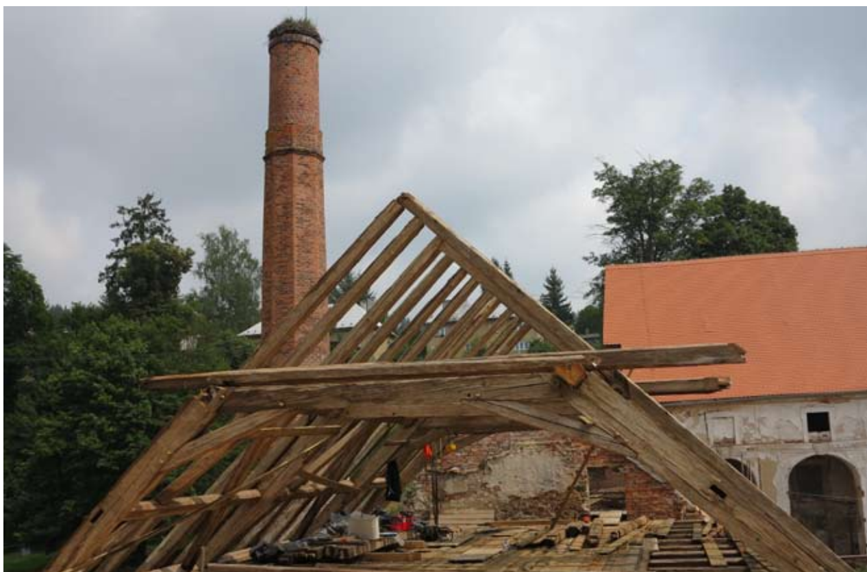
Vztyčování barokního podmokepského korvu nad obnovenou ruinou lihovaru, červenec 2014 (foto Jan Trnka)
