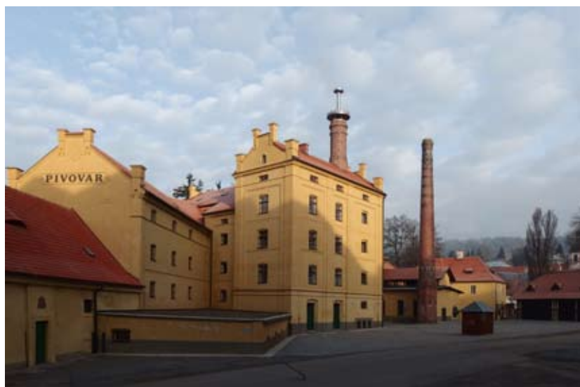
Areál pivovaru po dokončení stavebních prací, leden 2014 (foto Pavel Koderá)
