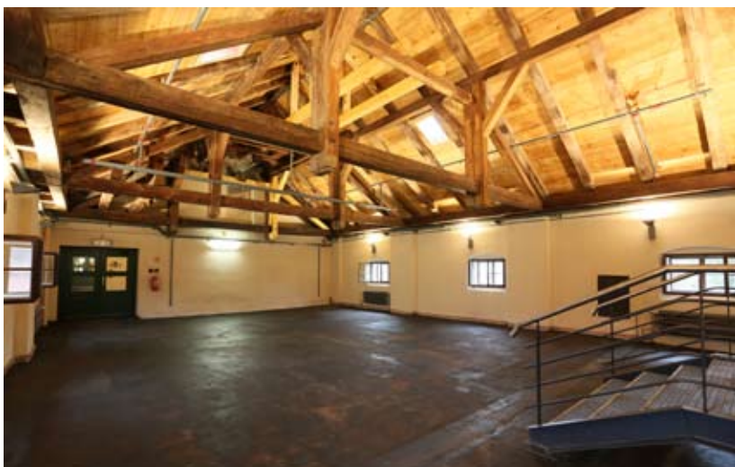
Prostor budoucího studijního depozitáře v podkroví pivovaru, prosinec 2013 (foto Kateřina Uksová)
