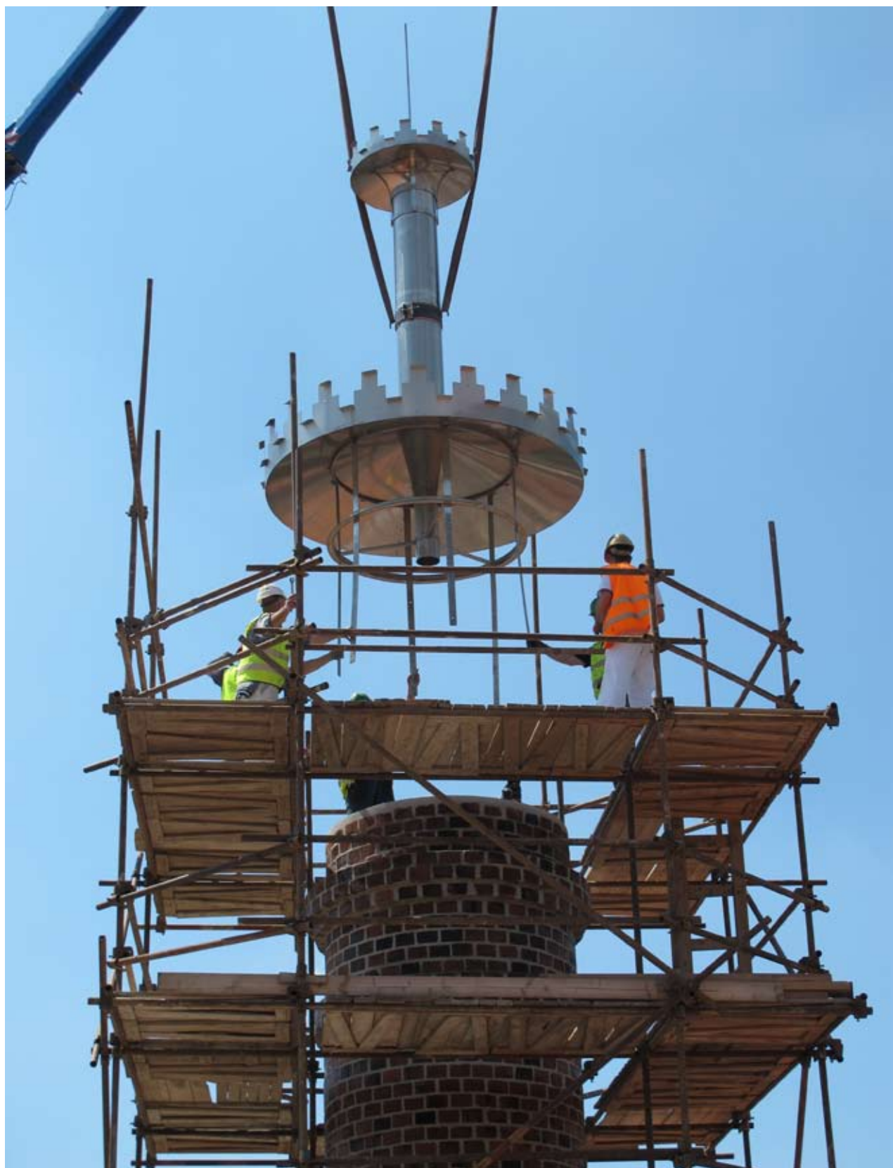
Osazování tzv. „klobouku pana starého“ na nově obnovený párník sladovny, červen 2013 (foto Jan Trnka)
