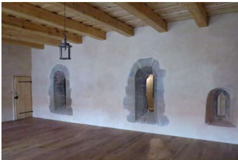
Obnovený prostor románského foyer, duben 2015 (foto Jan Trnka)
