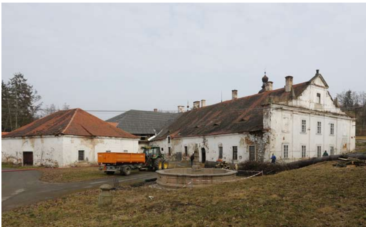
Počátek památkové obnovy hospodářského dvora i navazujícího parteru bývalého klášterního nádvoří v březnu 2014 (foto Kateřina Uksová)
