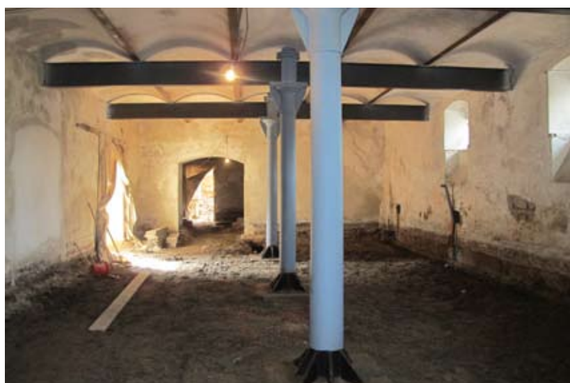
Sanace podlah dolního humna, duben 2013 (foto Jan Trnka)
