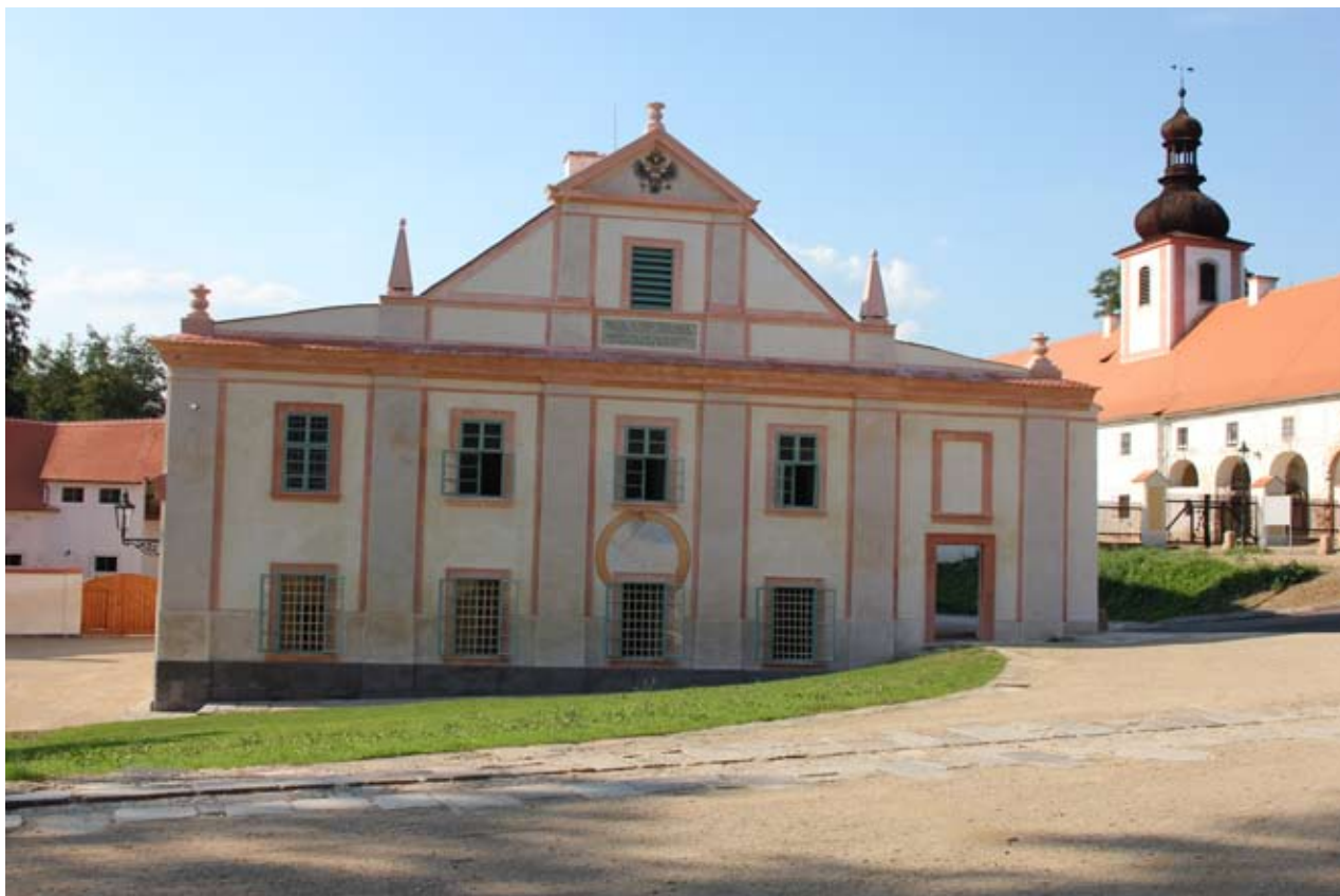
Hlavní průčelí správní budovy hospodářského dvora po restaurování a obnově slunečních hodin (foto Nadežda Svobodová)
