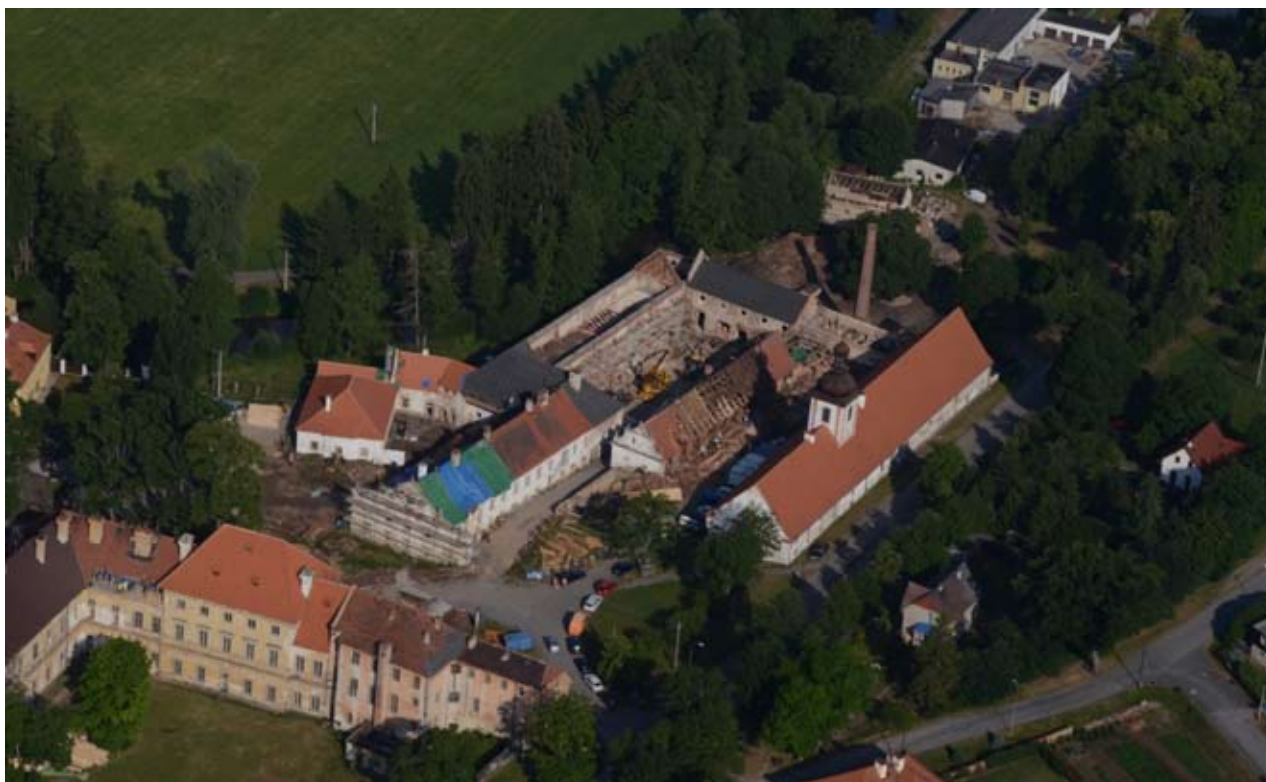
Objekty hospodářského dvora během rekonstrukce (foto Ivo Kornatovský)
