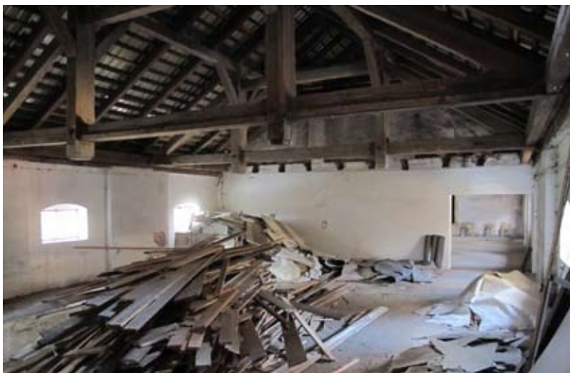
Obnova podkrovních prostorů sladovny, říjen 2012 (foto Jan Trnka)
