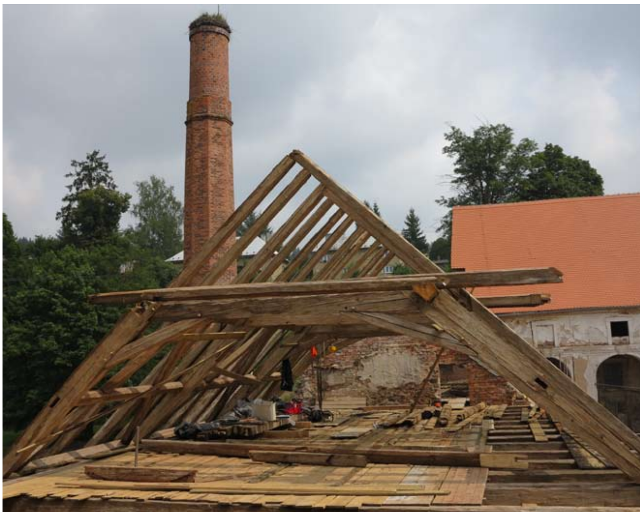
Barokní krov z Podmokel instalovaný na budově lihovaru v Plasích (foto Jan Trnka)
